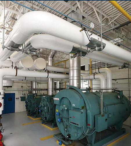
Un système d'échappement bien conçu peut éviter des inefficacités de chaudières, des arrêts de brûleurs et des interruptions de flammes durant la mise en marche.
